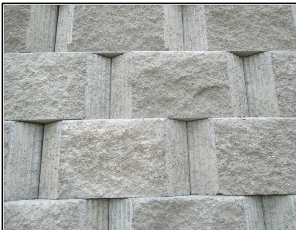
STA.4+600~4+978 옹벽 시공 상태(원주방향)
