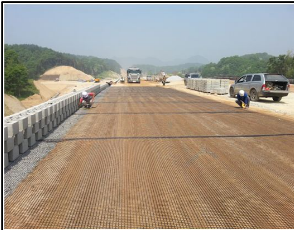
STA.4+600~4+978 그리드 길이 측정(원주방향)
