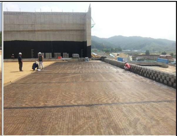
STA.4+600~4+978 그리드 길이 측정(원주방향)
