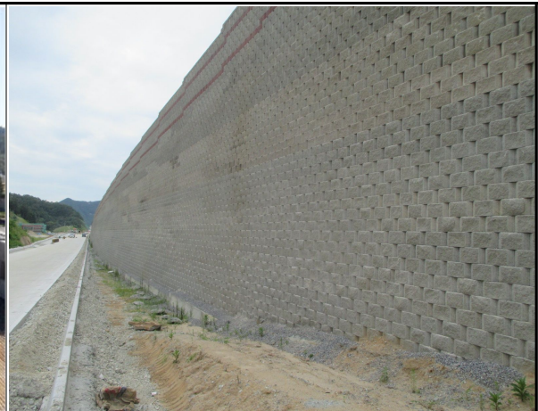
STA.4+600~4+978 옹벽 전경(원주방향)
