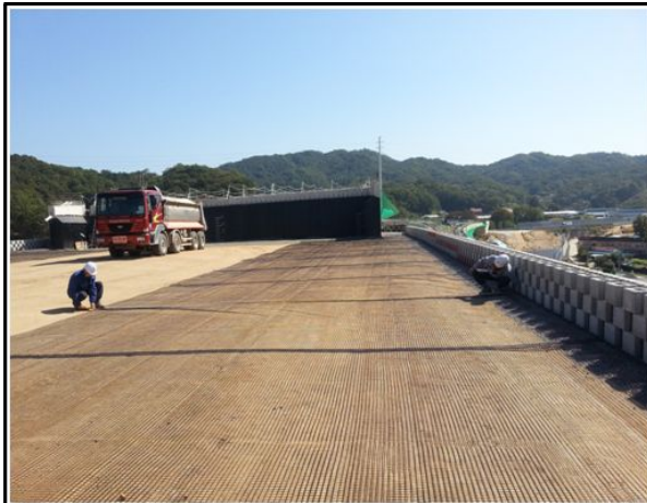
STA.4+600~4+978 그리드 길이 측정(원주방향)
